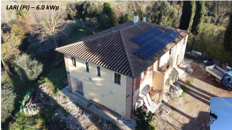
VILLE MONOFAMILIARI – LARI (PI): Foto aerea con Drone eseguita a fine lavori di installazione impianto fotovoltaico.
