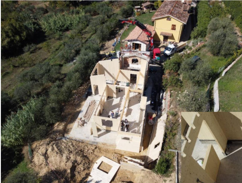
VILLA MONOFAMILIARE – LARI (PI): Demolizione e realizzazione di nuova unità immobiliare
